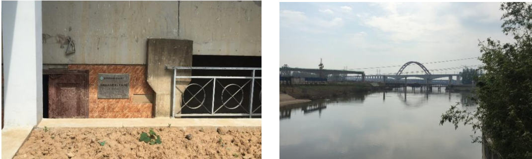
图 4-33 五里闸断面现状
