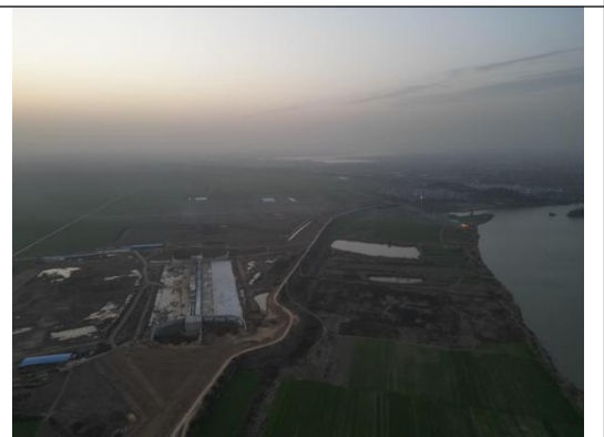
东风湖排涝站（在建）
