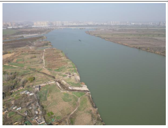
山口老河口入河排涝口
