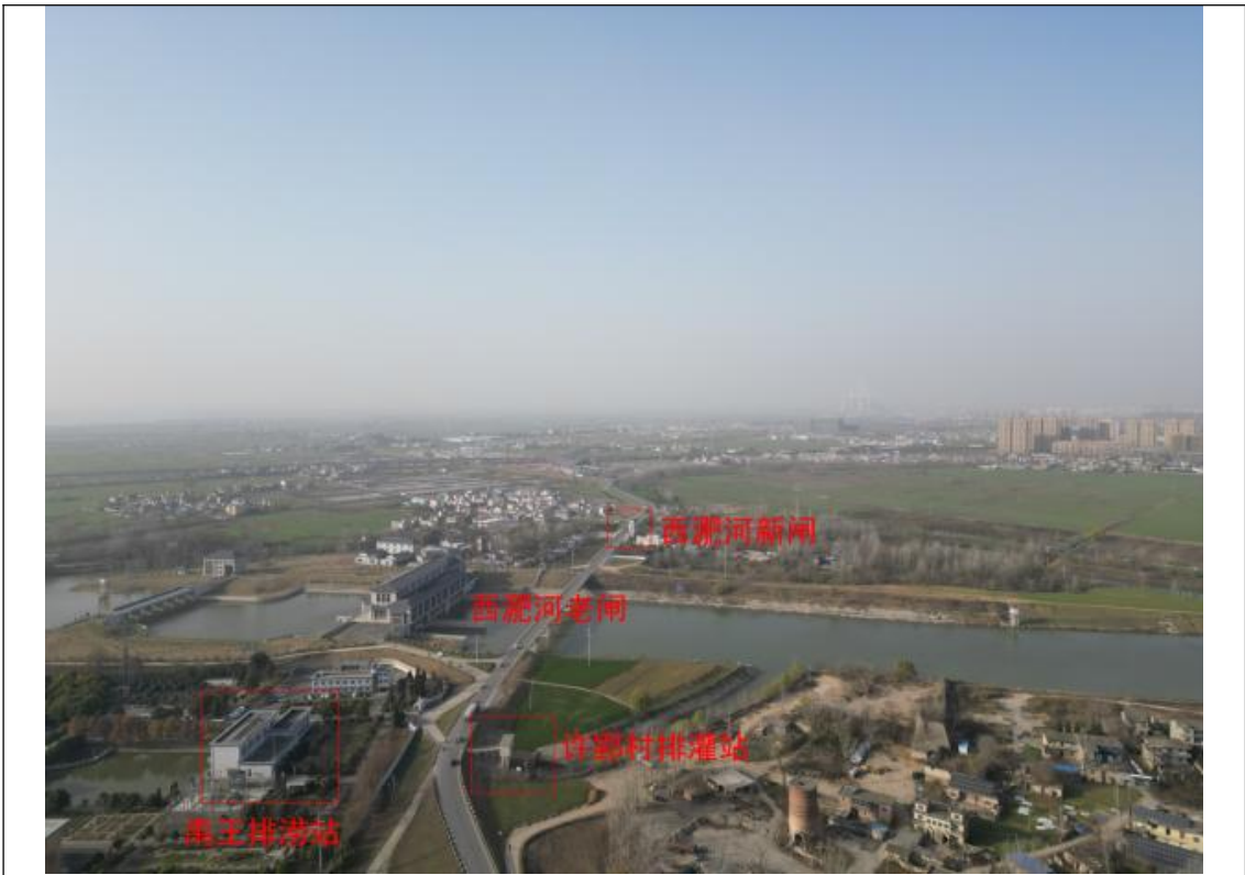
淮河入淮口处（西淝河新闸、西淝河老闸、禹王排涝站、许郢村排灌站）
