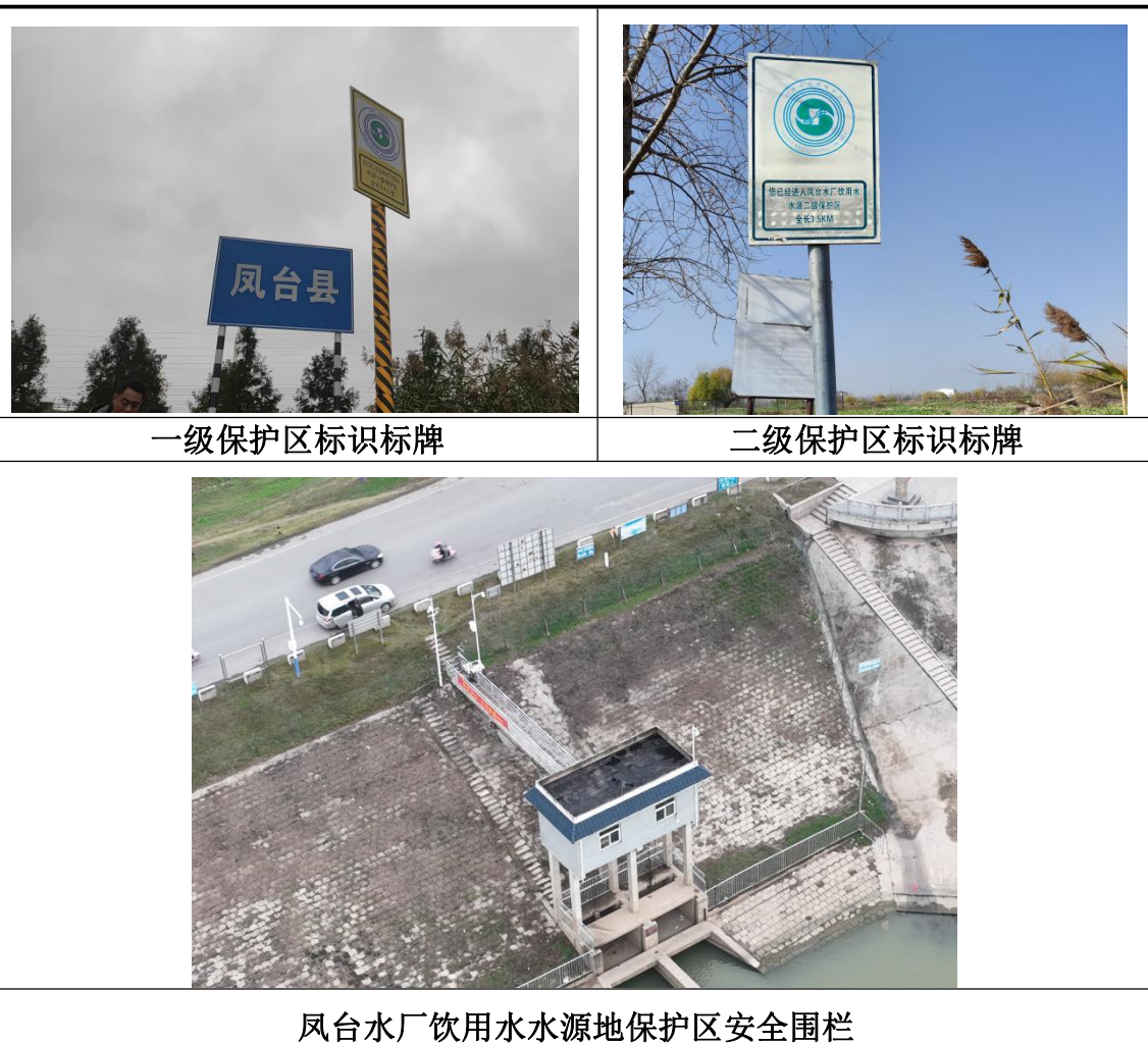
图 3.3-1 水源地规范化建设情况
