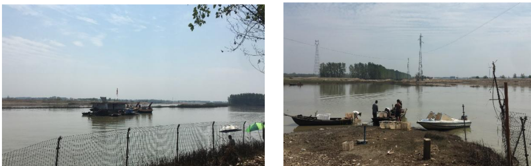
图 4-30 白洋淀渡口断面现状
