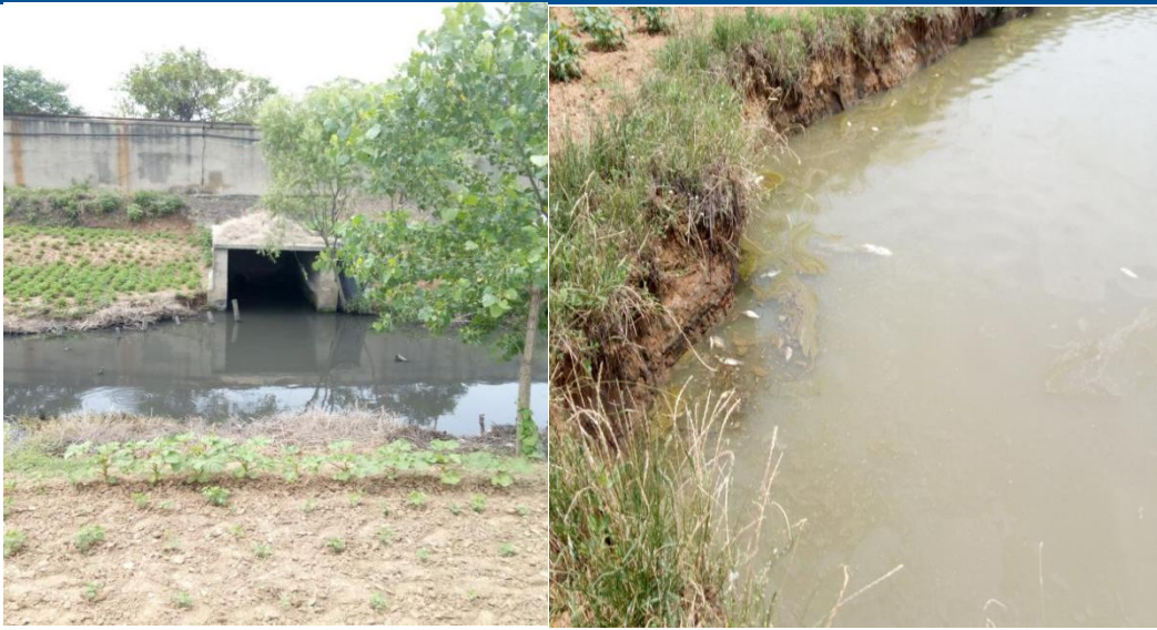
图 4-49 新集一矿混合入河排污口 图 4-50 新集二矿工业入河排污口河道
