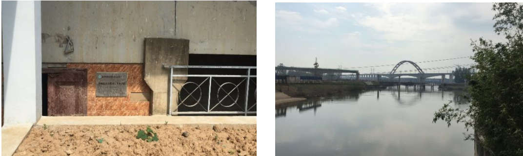
图 4-33 五里闸断面现状
