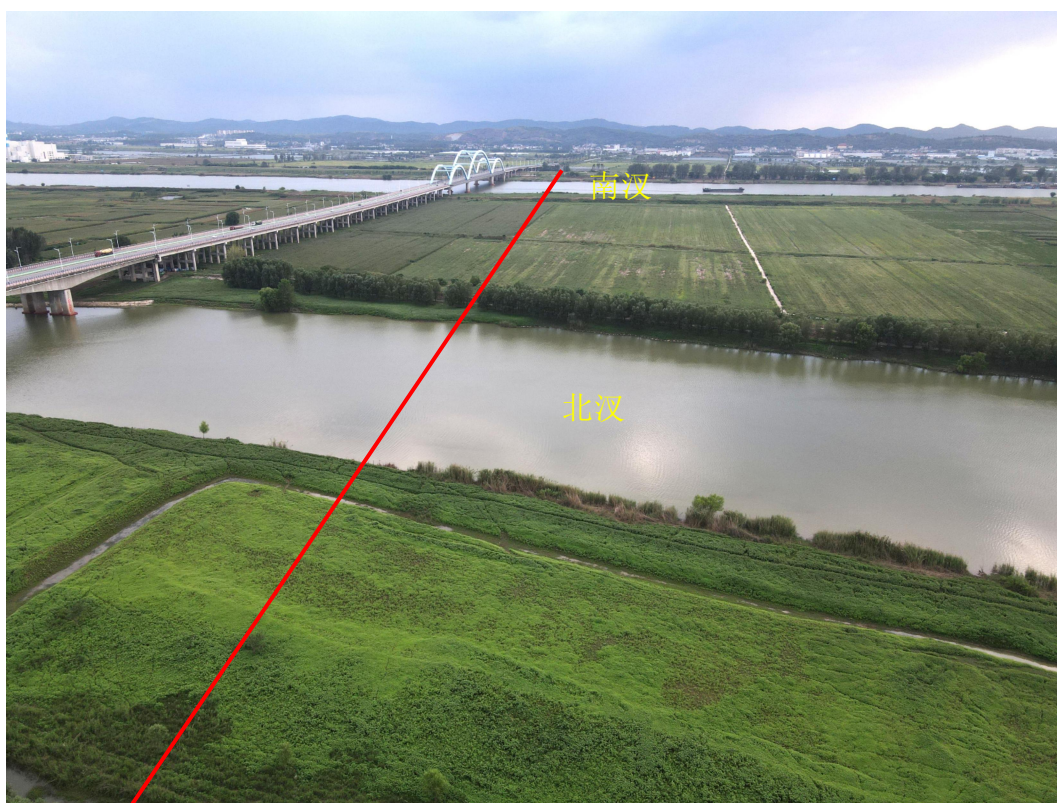
跨越淮河现场照片
