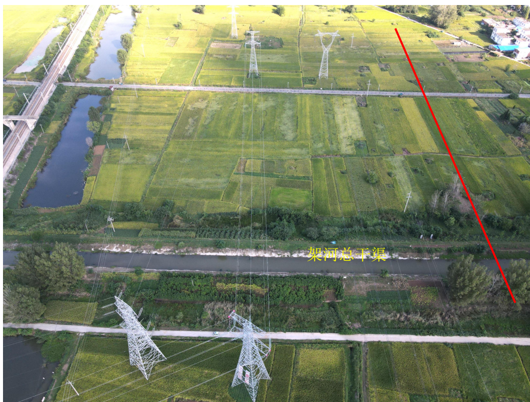
跨越架河总干渠现场照片
