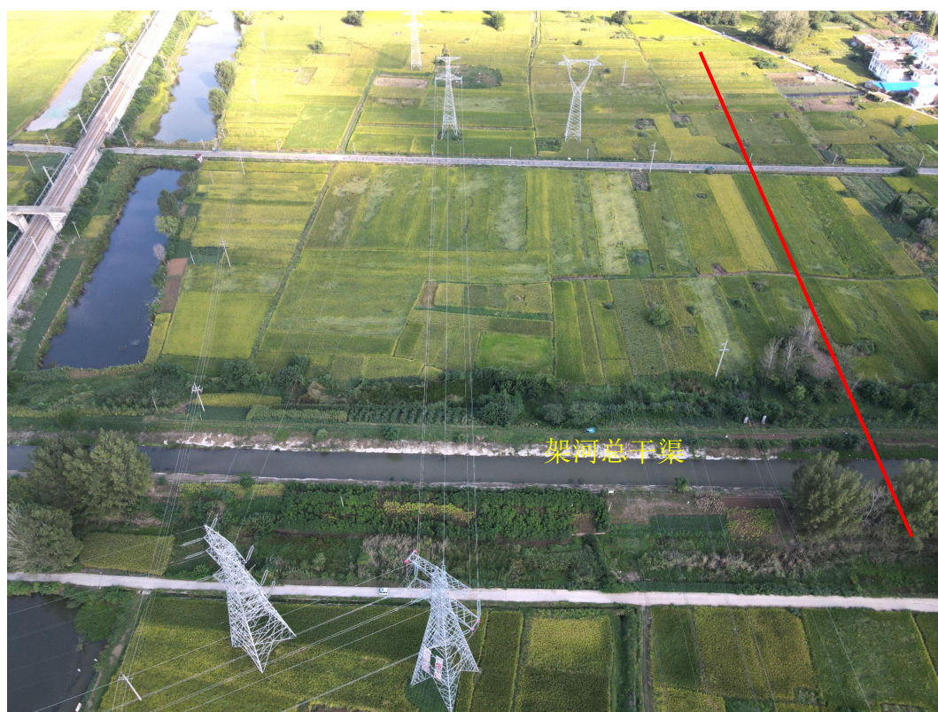
跨越架河总干渠现场照片
