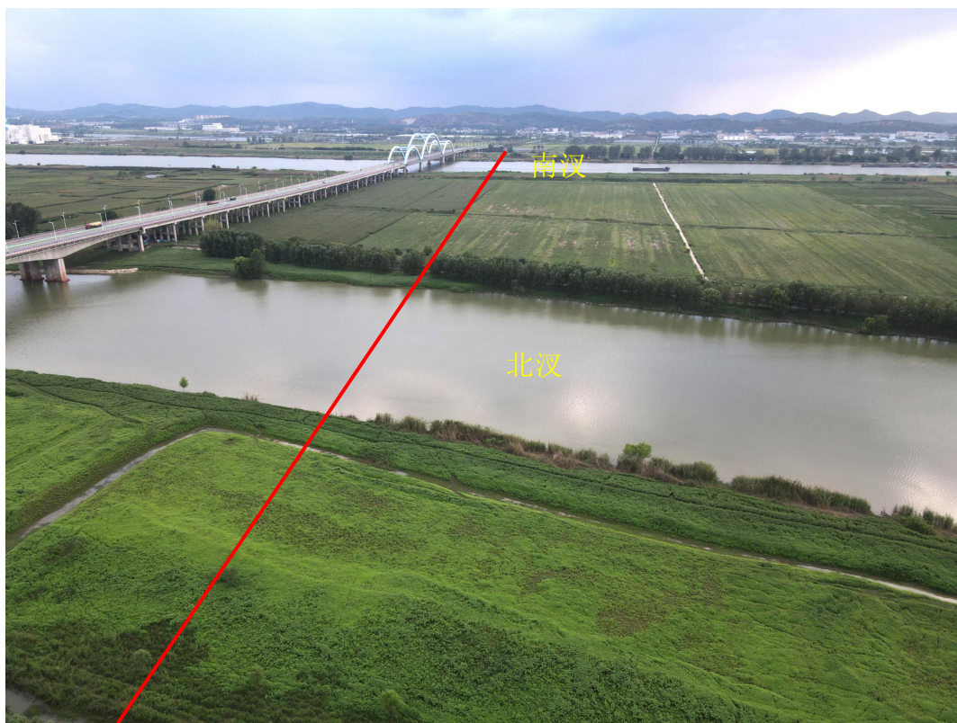
跨越淮河现场照片
