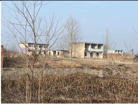
光伏阵列区南侧废弃房屋
