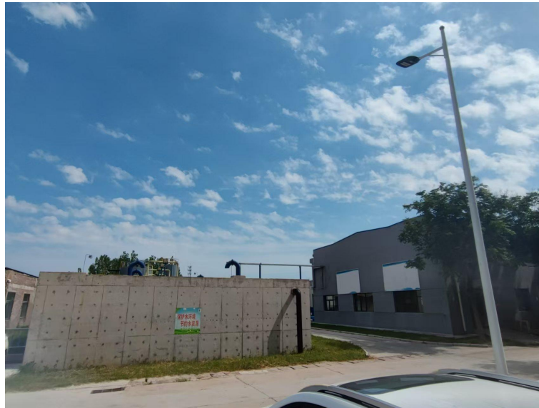
图 5.4-1 依托工业场地生活污水处理站
