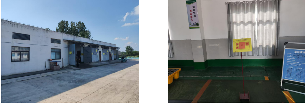
图 5.4-1 依托工业场地危废暂存间
