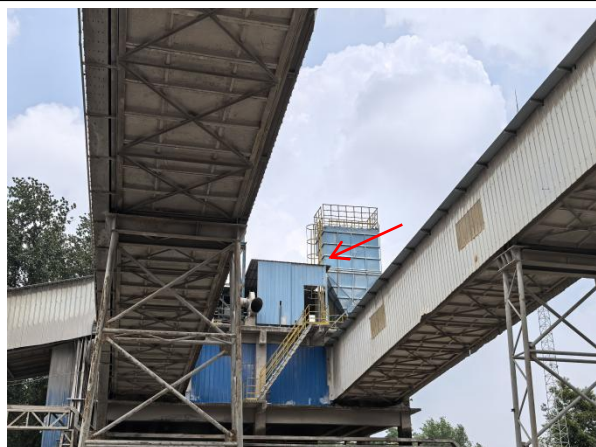
水泥窑窑尾高效布袋除尘器
