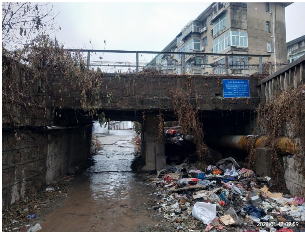
图3.6-7 邻近新建1-4.0m、1-2.5m框架涵附近的既有K10+701处2-3.1m框架涵
