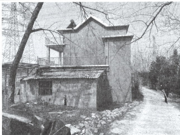
义安区西联镇东城村五组 9 号 1 层坡顶民房
