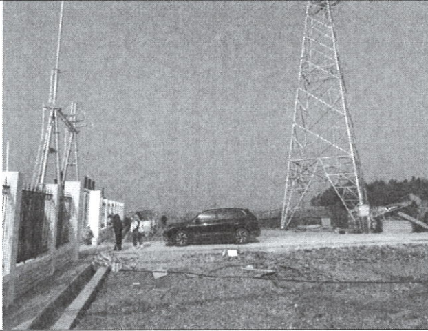
110kV 东湖升压站北侧
