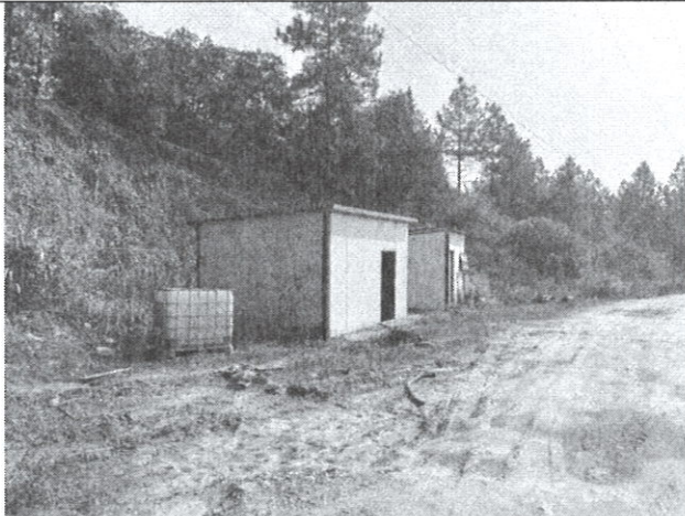
义安区西联镇东湖村废弃矿厂 1 层平顶板房
