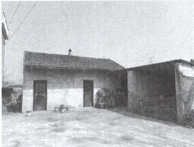
义安区西联镇东城村六组赵某家 1 层坡顶民房
