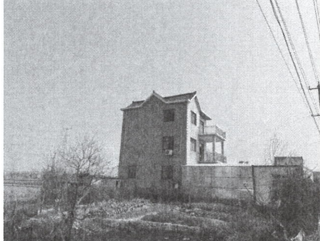
义安区西联镇东城村六组查某家 3 层坡顶民房
