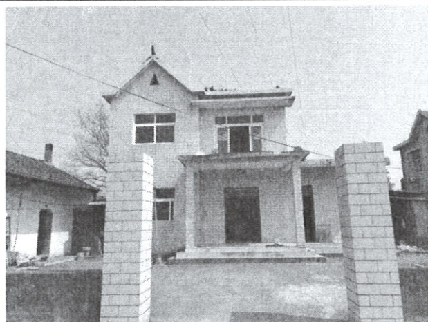
义安区东联镇水许村十五组 24 号 2 层坡顶民房
