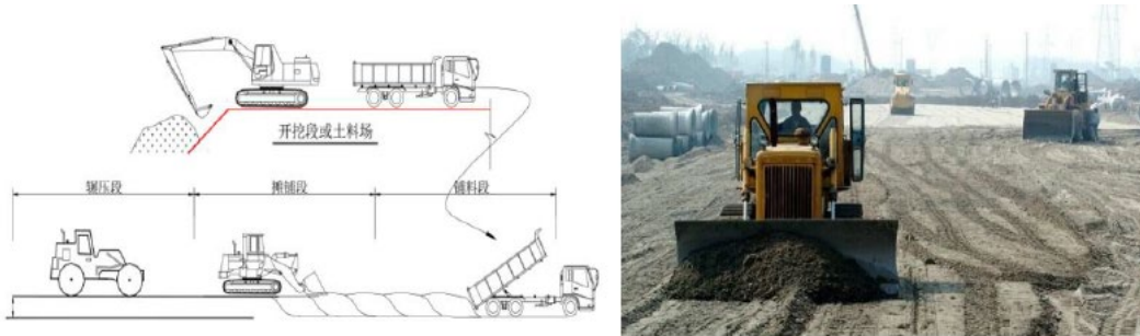
图 3.7.1-6 土方回填夯实示意图
