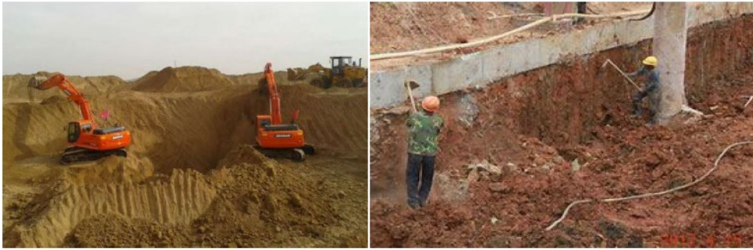
图 3.7.1-5 机械+人工辅助开挖示意图
