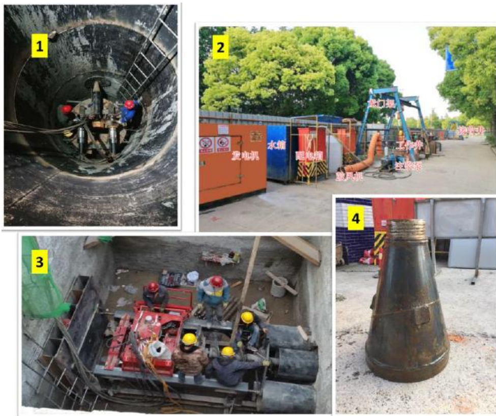
图 3.7.3-1 微型顶管施工现场图
