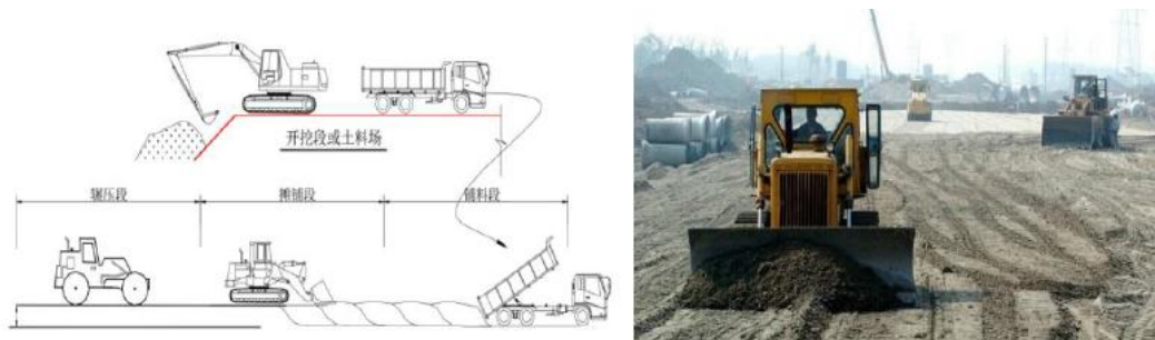
图 3.7.1-6 土方回填夯实示意图
