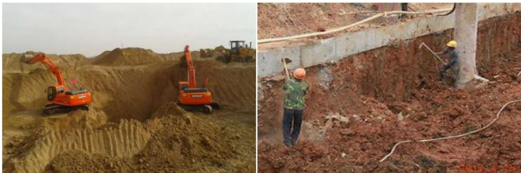
图 3.7.1-5 机械+人工辅助开挖示意图
