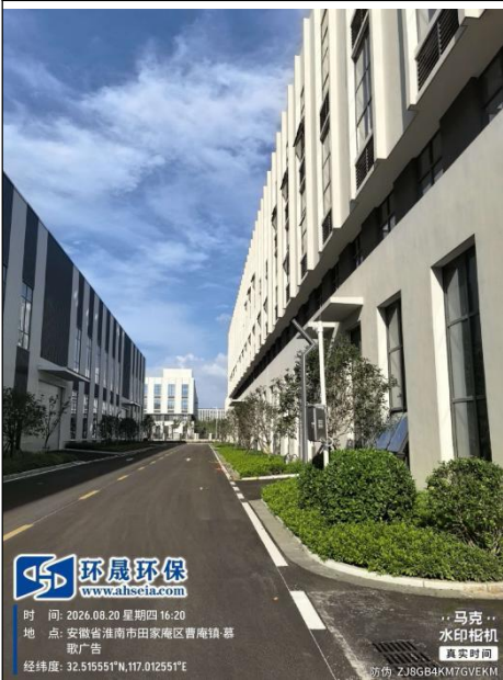
项目北侧厂界
